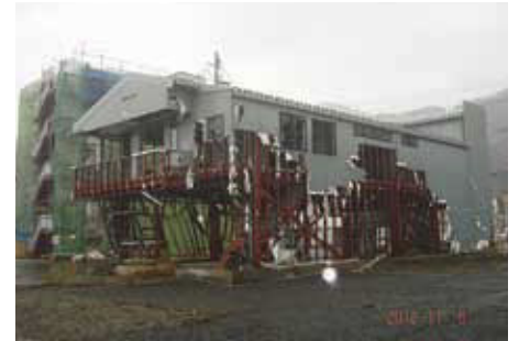
(被災を受けた“釜石市街地”)
