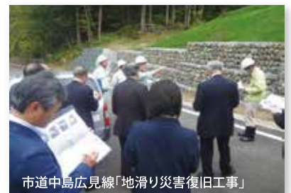
市道中島広見線「地滑り災害復旧工事」
